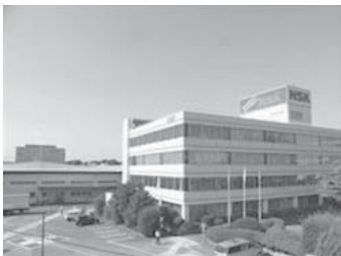
図1 日本精工(株)藤沢工場全景 (出典：同社ホームページより)
