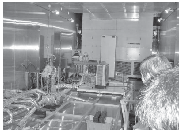
図5 ヒートポンプ性能評価試験設備の環境試験室内
