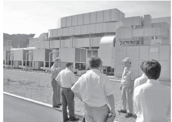
図9 ヒートポンプ開発試験設備のある実験棟(屋外)
