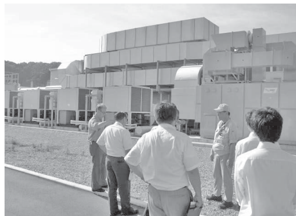
図9 ヒートポンプ開発試験設備のある実験棟(屋外)
