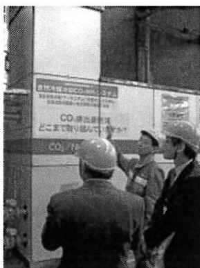
図4 \text{NH}_3 \cdot \text{CO}_2 自然冷媒循環システムを実験会場で技術者から説明を受ける参加者。食品工場では、冷凍機械室のみに少量の \text{NH}_3 を保有し、室外から加工場には、 \text{CO}_2 の冷媒配管のため非常に安心である。
